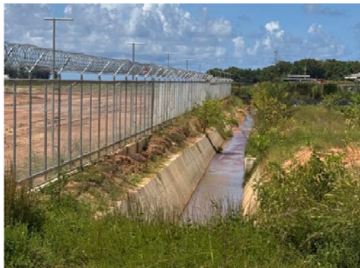
รูปที่ 3.1-1 (17) การขุดลอกกระบระบายน้ำใน ทภก.
